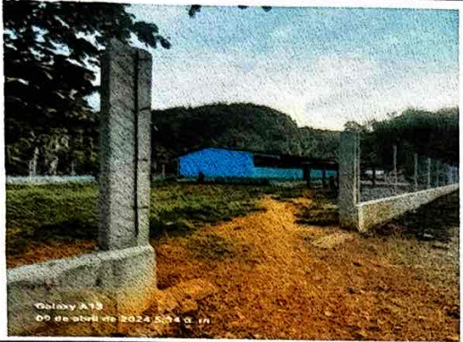
Foto 1: Instalación de portón.
