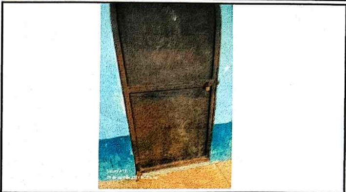
Foto 2: Cambio de puertas por deterioro.
