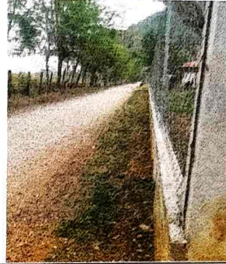
Foto 2: Repello de muro perimetral.
