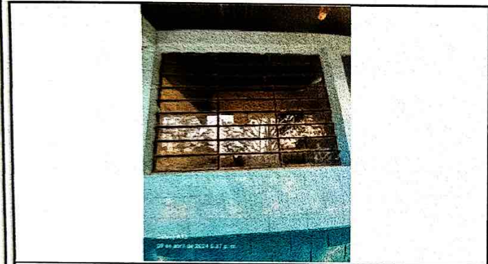
Foto 3: Sustitución de vidrios por valcones.
